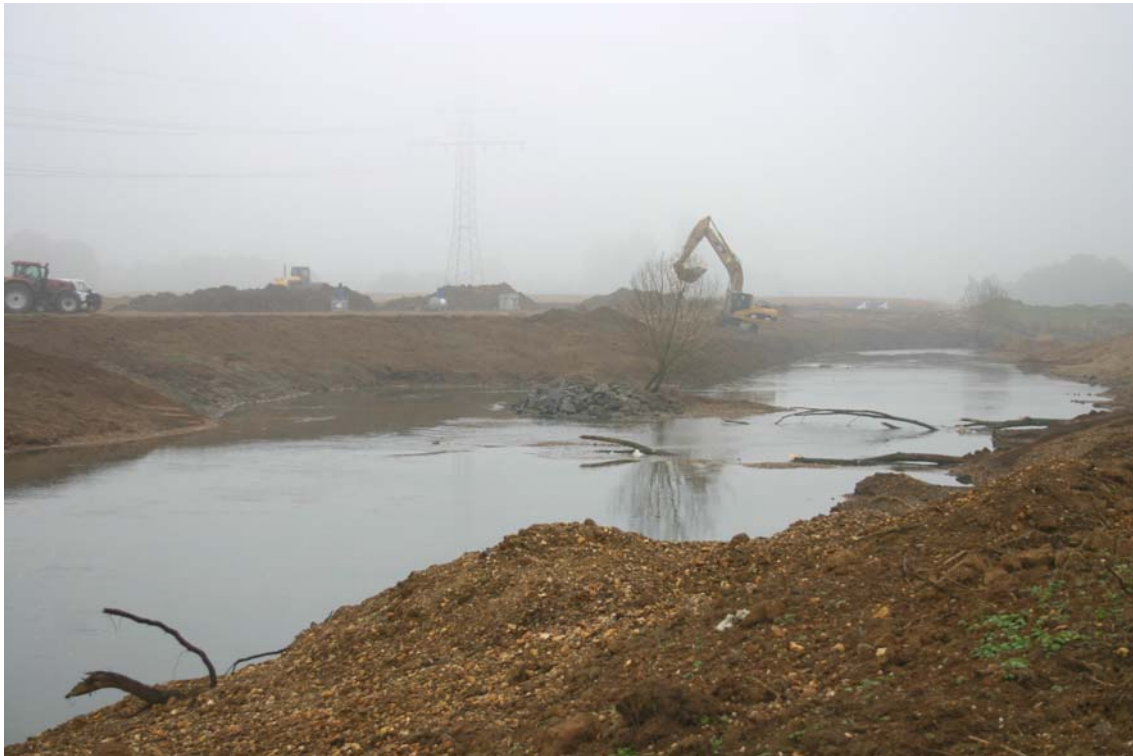
Bild 5: Totholzeinbau
