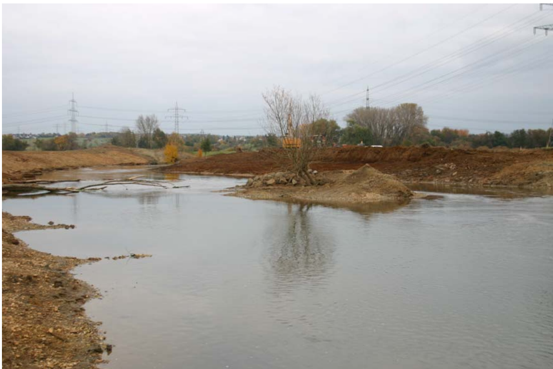
Bild 6: Totholzeinbau mit neuer Insel und Geschiebedepot
