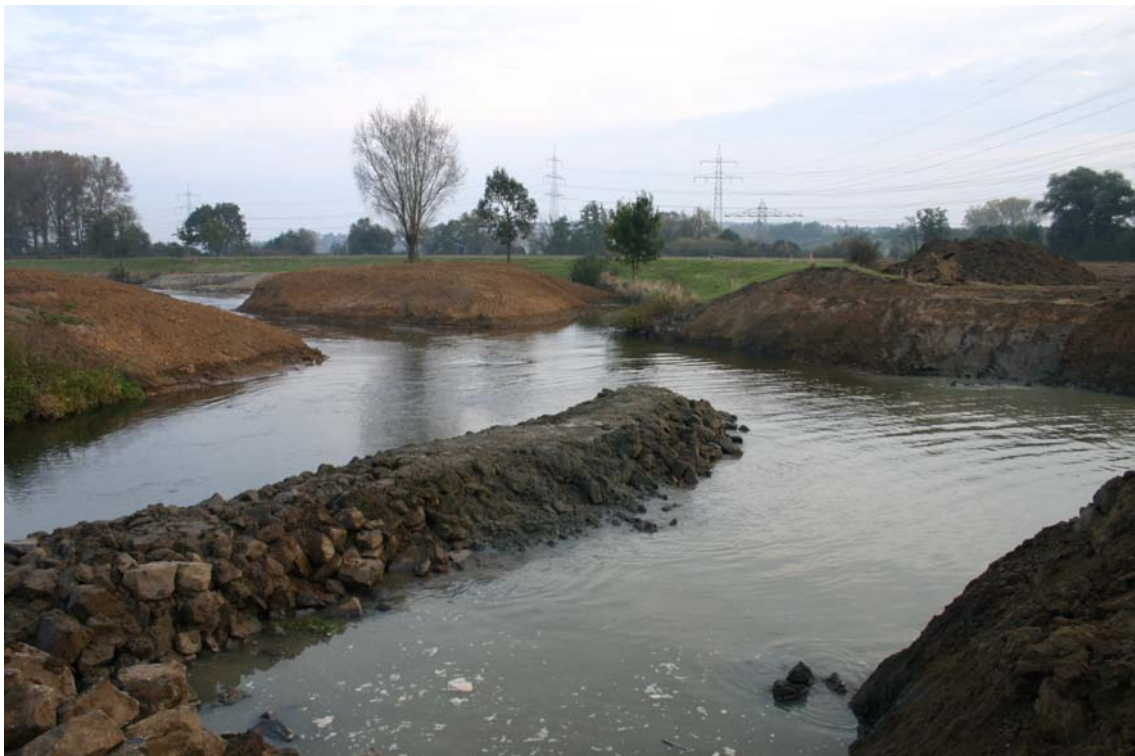
Bild 4: Anlage einer neuen Schleife mit mehreren Stillgewässern und Insel
